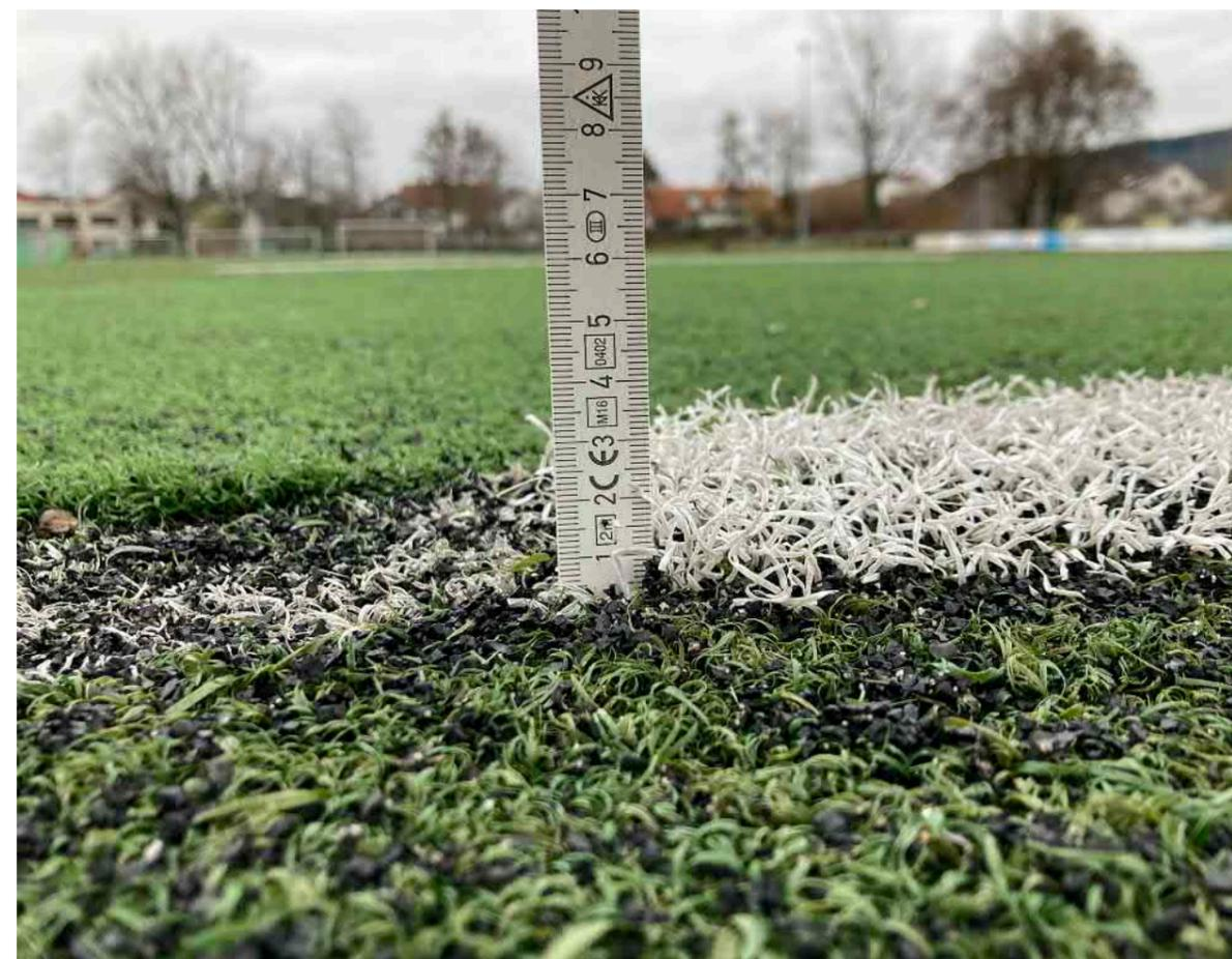
Bild 1: Vergleich abgespielter Platz zu in 2022 sanierter Torlinie. Das Bild verdeutlicht die Abnutzung der 15 Jahre alten Kunstrasenfasern.
